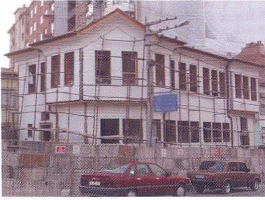
Müze binasında restorasyon çalışması yapılıyor.
