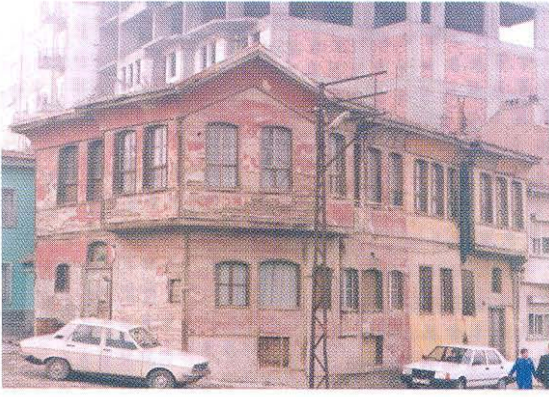
Binanın müze olmadan önceki hali.
